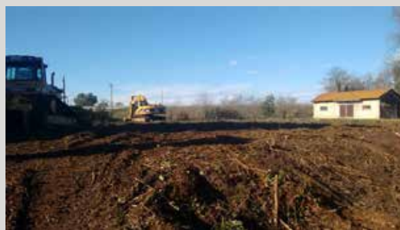
L'area interessata dal posizionamento dei tubolari
